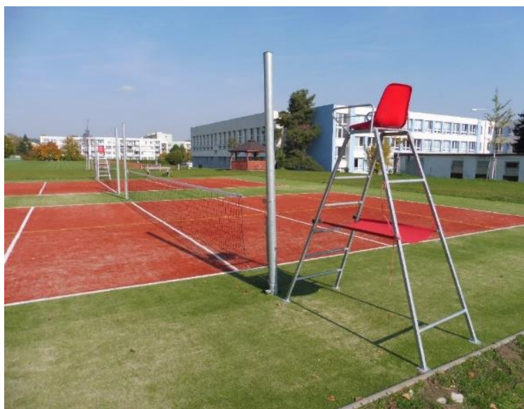
Nově zbudované hřiště pro volejbal a nohejbal.
