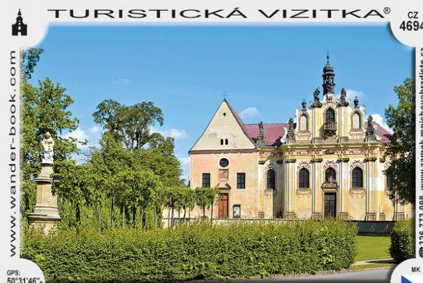
Kostel Tří králů a kaple sv. Anny v Mnichově Hradišti
